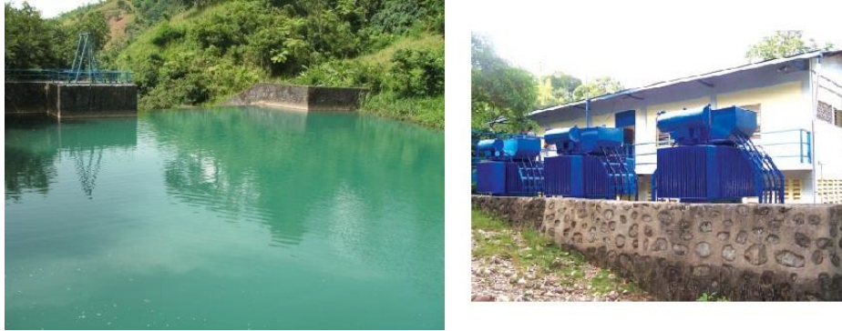
Figure 1-18.- La centrale Hydro-électrique de Saut-Mathurine
