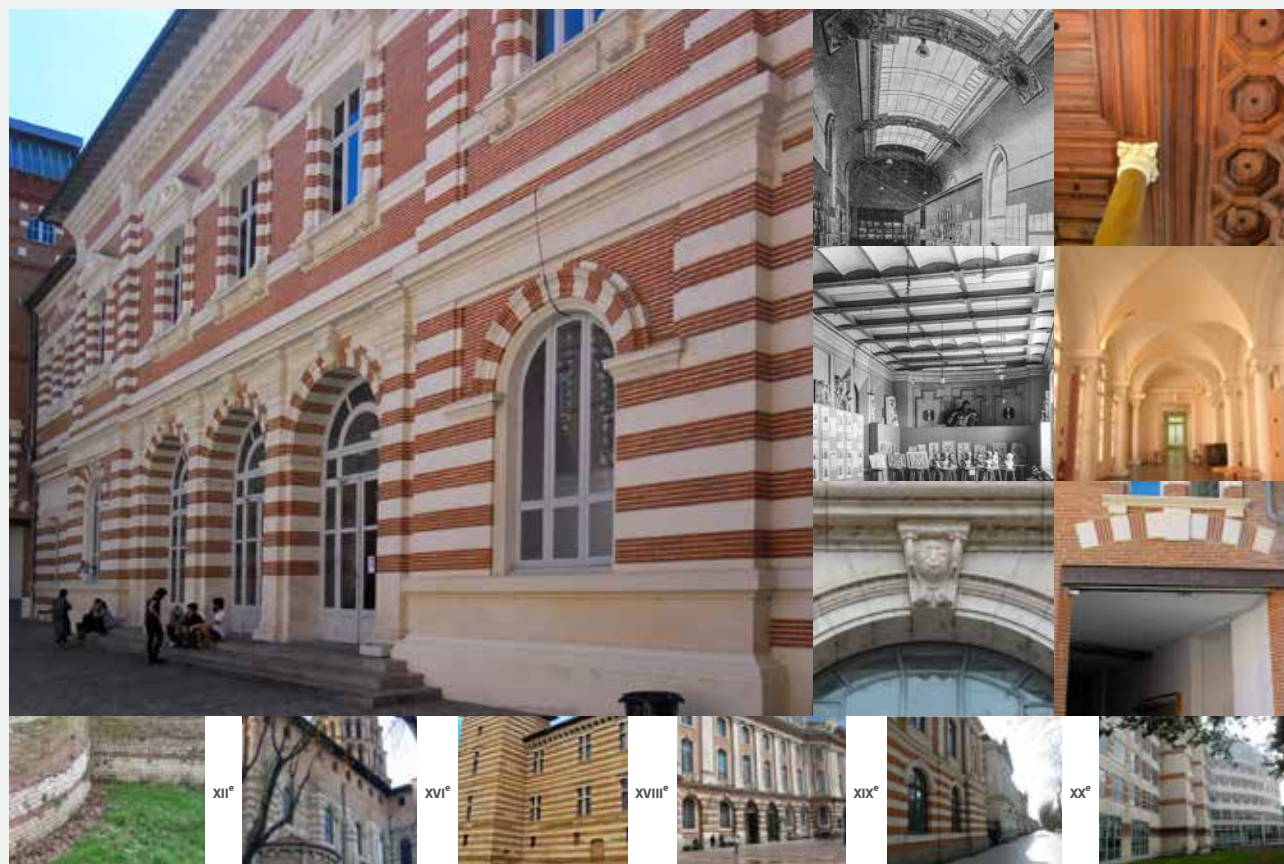
Fig. 2 : Palais des Arts, façade sur cour. En bas, références à l'appareillage romain. À droite, différentes techniques constructives. Montage photo JHF.
