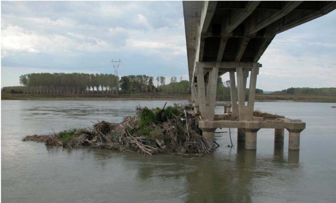
Figura 2. “Isole di detriti” formati contro i piloni del ponte di Pieve Porto Morone a causa della presenza dei piloni in alveo.
