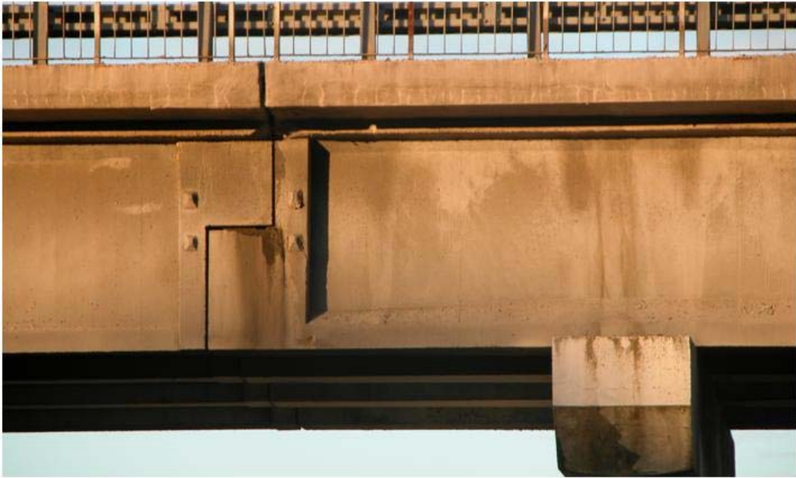
Figura 3. Immagine della sella Gerber del ponte di San Nazzaro.
